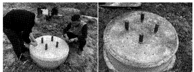
图 9 线路基础表面处理
