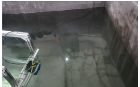
图 4 实验室混凝土水池
