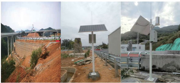
图 7 公路边坡现场与监测站点图
